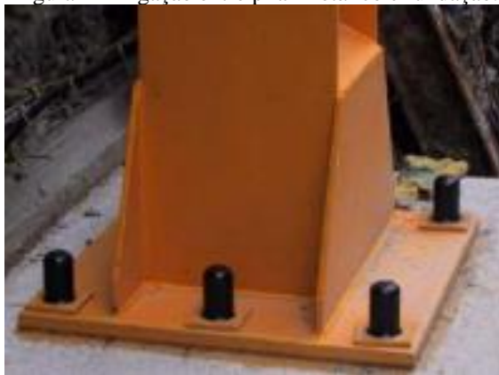
Figura 1 – Ligação entre pilar metálico e fundação.
